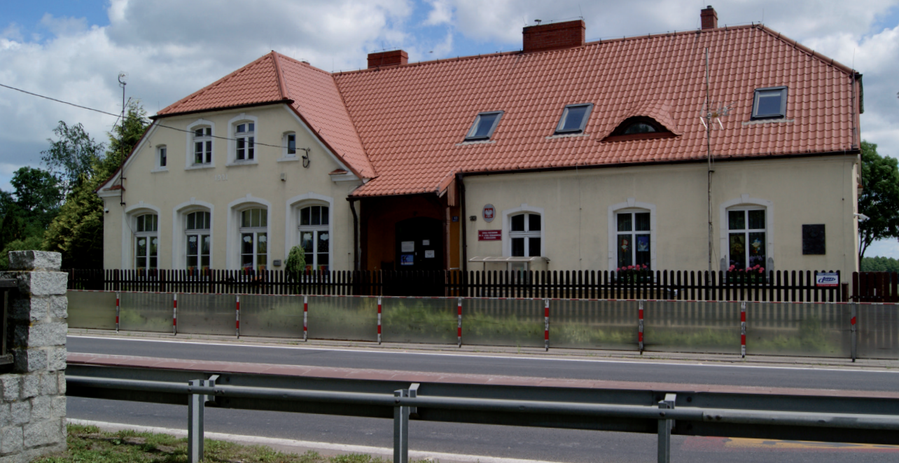
Fot. 4 Budynek Szkoły Podstawowej im. ks. Leona Formanowicza w Modliszewku (fot. J. Kobus)
